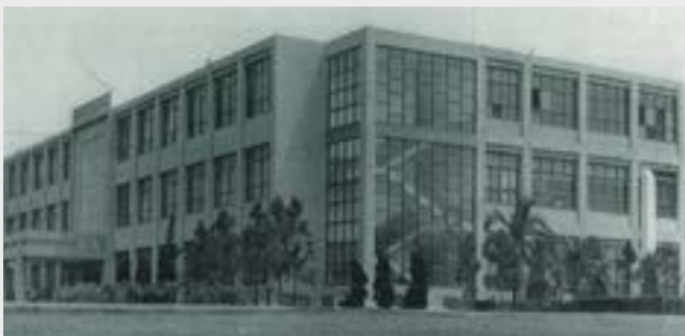
1960年代的竹銘館，當時部分空間是教室，早期IBM第一代真空管計算機安裝於一樓右翼實驗室
